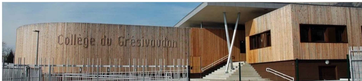
Collège du Grésivaudan à Saint-Ismier (Isère)
